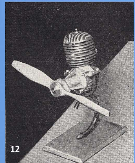
10 cm 3 - Glühkerzenmotor vom VEB Zentralwerkstätten Berlin (Zeitschrift Der Modellbauer 1958)
